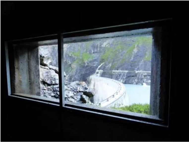
Ausblick aus einem Fenster im Tunnel auf die Staumauer.
