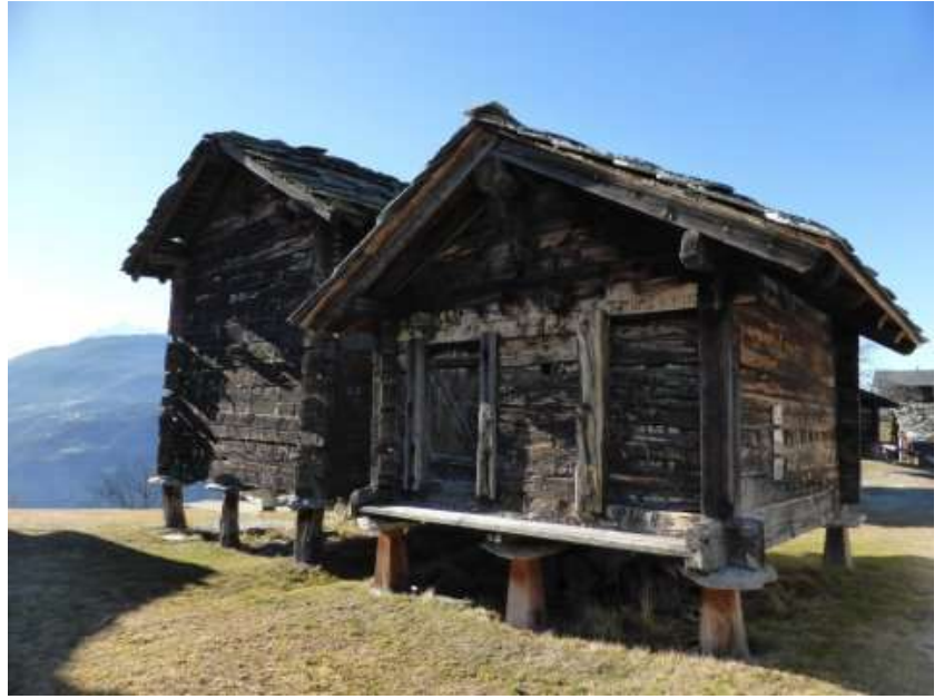
...und Speicher blieben hier erhalten und werden sorgsam gepflegt.
