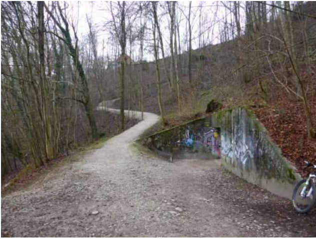
Durch den spassigen Tunnel in Bremgarten geht's rechts hinein.
