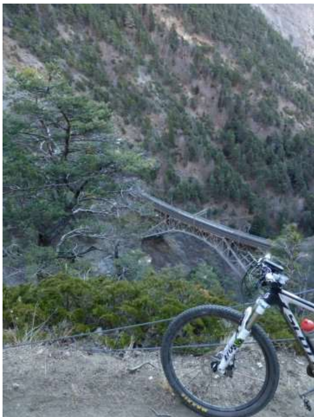
Hoch über der Bietschtalbrücke...
